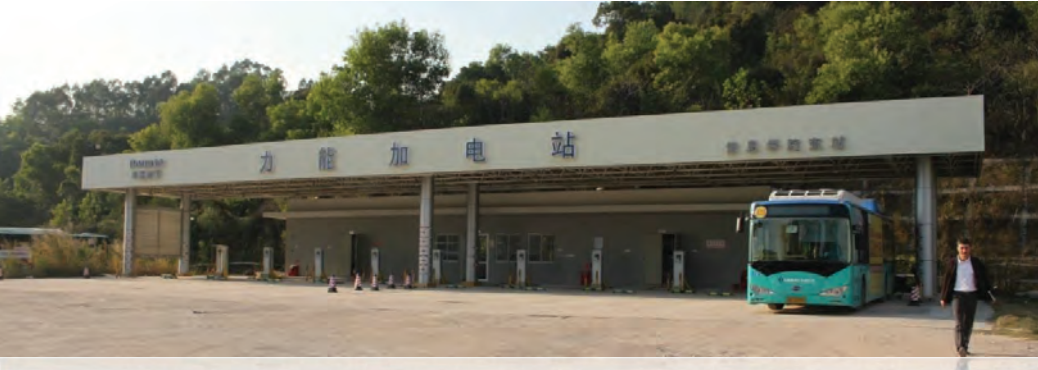
Çin / Shenzhen kentinde çalışan BYD firmasına ait elektrikli otobüs ve Dolum İstasyonu
